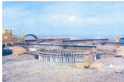
Figure 13a. Foundation Bolts Ready for Concrete Pour
